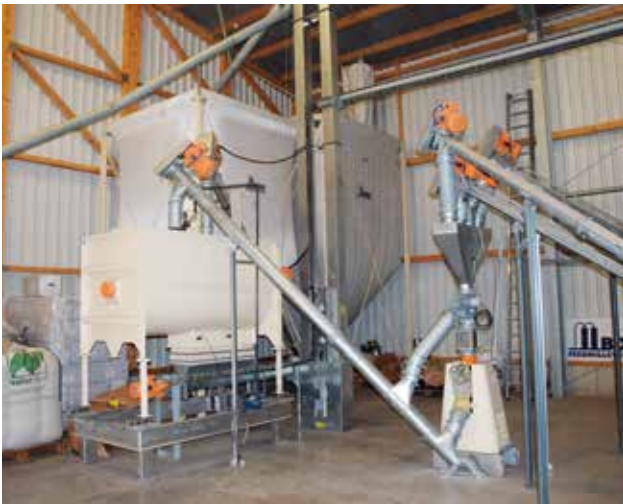
Herstellung von Legehennenfutter 2 t/h in Biebertal, Deutschland Production of layer feed 2 t/h in Biebertal, Germany
