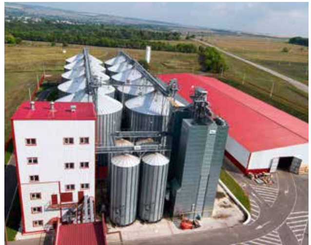
Getreidelagerung 30.000 t mit Reinigung und Trocknung in Belgorod, Russland Grain storage 30,000 t with cleaning and drying in Belgorod area, Russia
