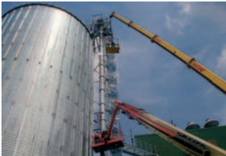
Подъемно-транспортное оборудование для загрузки и выемки круглого силоса с транспортировочными трубопроводами со скоростью до 300 т/ч.
