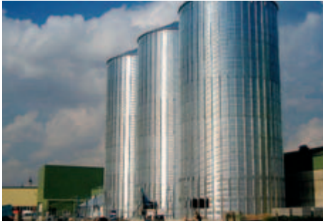
Silokörper aus beidseitig sendzimirverzinkten Stahlwellblechen (Stahlgüte ST52). Die Bleche können auch mit einer speziellen Farbbeschichtung geliefert werden. Die Silos besitzen einen Prüfbescheid vom zuständigen Ministerium.
