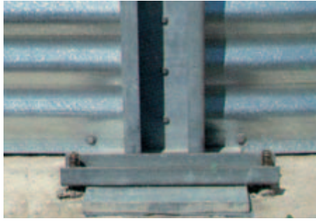
Опоры силоса устанавливаются с внешней стороны и расположены так, чтобы вертикальные нагрузки тянули их к земле. Они закрепляются между собой и к листовой стали посредством высокопрочного винта модели от 8.8 до 10.9. Опорная подошва разрабатывалась таким образом, чтобы силос хоть и был прочно закреплен на фундаменте, но чтобы перемещение шло по горизонтали при загрузке и разгрузке.
